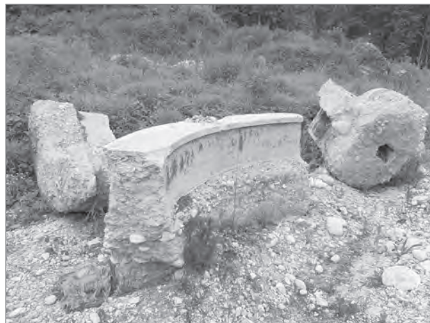
Slika 3: Degradacija vodnjaka pod nekdanjo upravno stavbo (vir: Štih, 2019)
