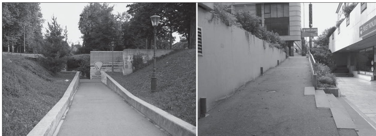
Slika 4: Primer funkcionalno ustrezne klančine v podhodih Tivoli in Ajdovščina v Ljubljani (foto: Petra Krajner).
