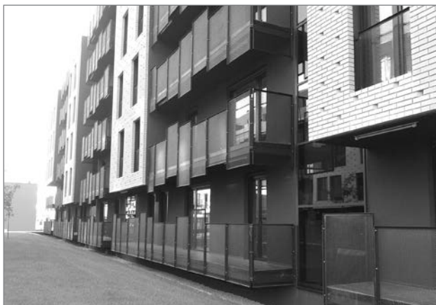
Slika 8: Izpostavljena pritlična stanovanja soseske Zeleni gaj, ki jim jemlje svetlobo še temno pročelje (foto: B. Železnik Bizjak).
