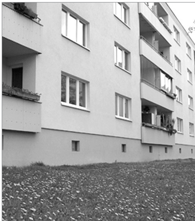
Slika 11: Zagotavljanje energetske učinkovitosti starejših zgradb (The-wosan – Dunaj, Avstrija; vir: internet 1)
