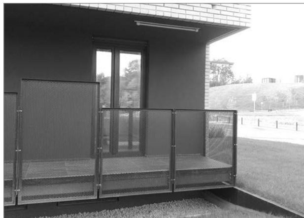
Slika 1: Soseska Zeleni gaj, Brdo, Ljubljana – izpostavljeno vogalno pritlično stanovanje; balkon je tik nad terenom, ograja je prosojna, na okna so dodane le temne tekstilne navojnice (foto: B. Železnik Bizjak).
