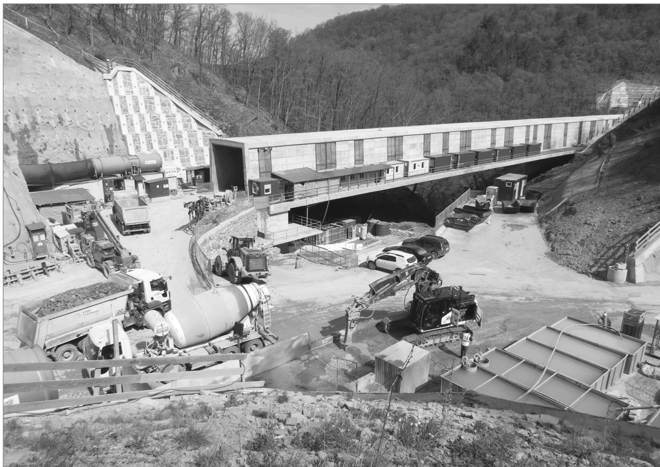
Slika 3: Gradbiščni plato pred portalom T2-Di, območje levega pritoka Glinščice (foto: Arhiv ZRSVN, Območna enota Nova Gorica, 19. 4. 2023)
