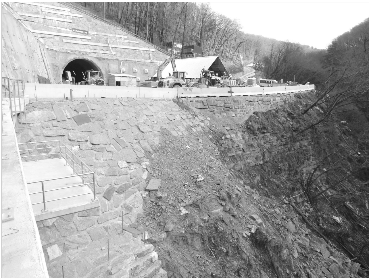
Slika 4: Območje gradbiščnega platoja z vodotesno ograjo pred portalom T1-Kp, desni breg Glinščice (foto: Arhiv ZRSVN, Območna enota Nova Gorica, 2. 2. 2023)
