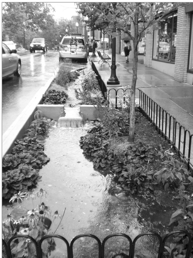
Slika 3: Deževni vrt za razbremenitev kanalizacijskega sistema v kampusu pensilvanske univerze v ZDA (vir: Sam, 2012)
