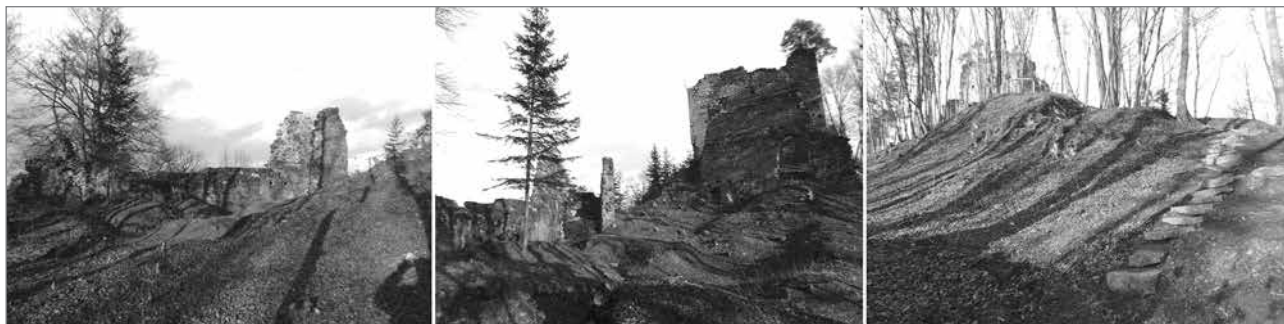
Slika 8: Fotografija gradu iz leta 2013 po zadnjem poseku gozda – pogled na severno, zahodno in južno fasado (foto: Marjan Potokar)
