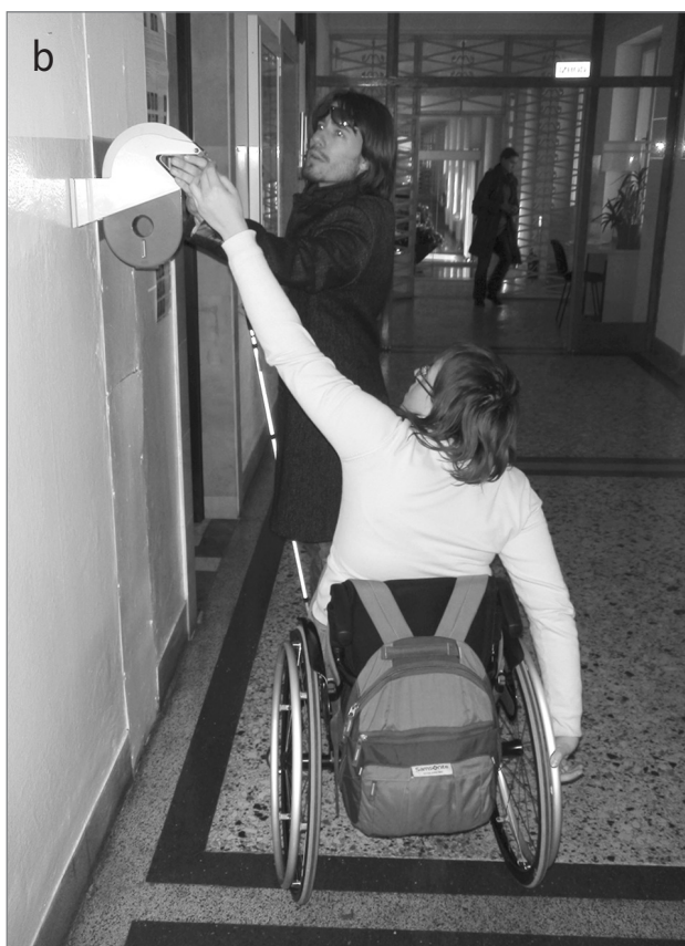
Slika 8: Čakalnice in dvorane – (a) dvorana s premičnimi sedeži, (b) primer neustrezne namestitve aparata za čakalne lističe (foto: arhiv UIRS)
