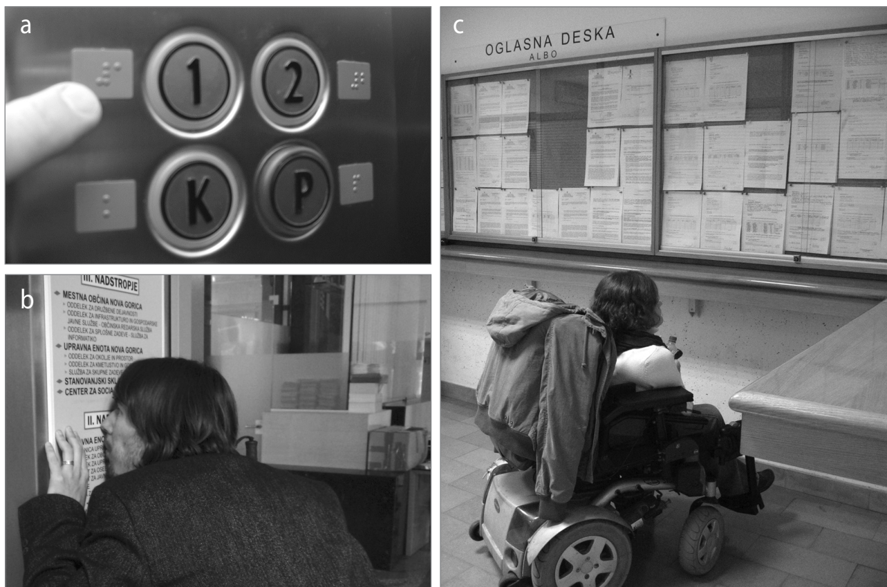
Slika 10: Sistem oznak in načini informiranja – (a) taktilne oznake v dvigalu, (b, c) primer neustrezne predstavitve informacij (foto: arhiv UIRS)
