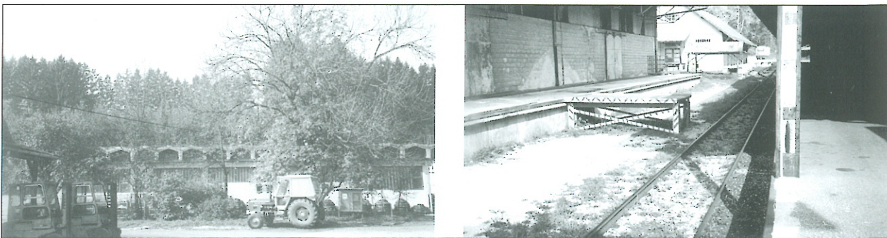
Slika 8: Kamnik – območje Fužin, kjer predlagamo severni kolodvor na zdaj opuščnem delu kemične industrije in slabo izkoriščnem skladiščnem prostoru (mešana raba površin: potniški terminal, poslovne, komercialne dejavnosti, stanovanjski program itd.).
